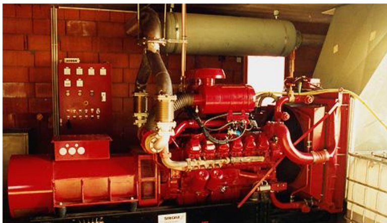
MAN cu 12-cilindrii, 700 cai putere, operat cu ulei vegetal
