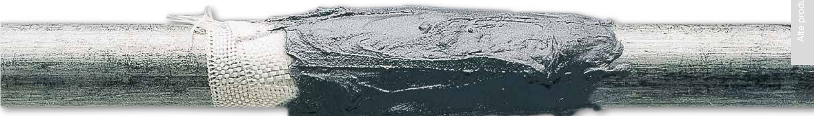
Repararea de urgență a unei conducte de apă
