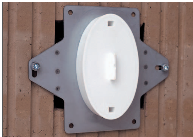
Fig. 5-4 Rama de montaj cu capac de curățare
