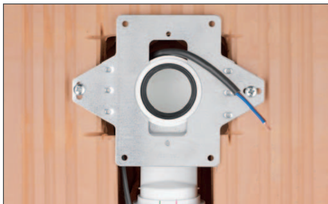
Fig. 5-3 Rama de montaj instalată
