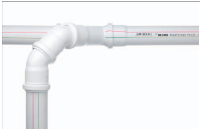
Fig. 5-19 Derivație în jos – instalată corect
