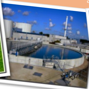
Statii de epurare
