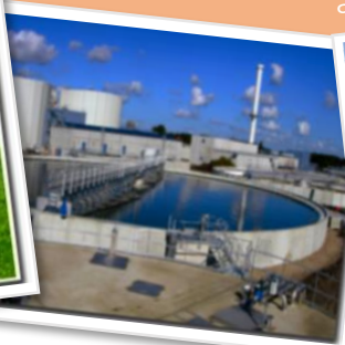
Statii de epurare
