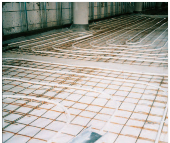
Sistem de plasă suport pentru țevi RAUBASIC
