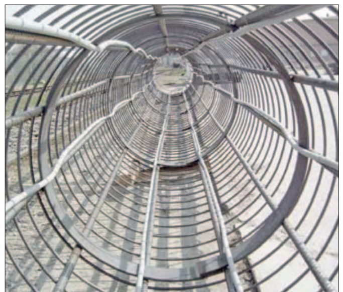
Tuburi RAUGEO collect PE-Xa montate pe colivia de armătură
