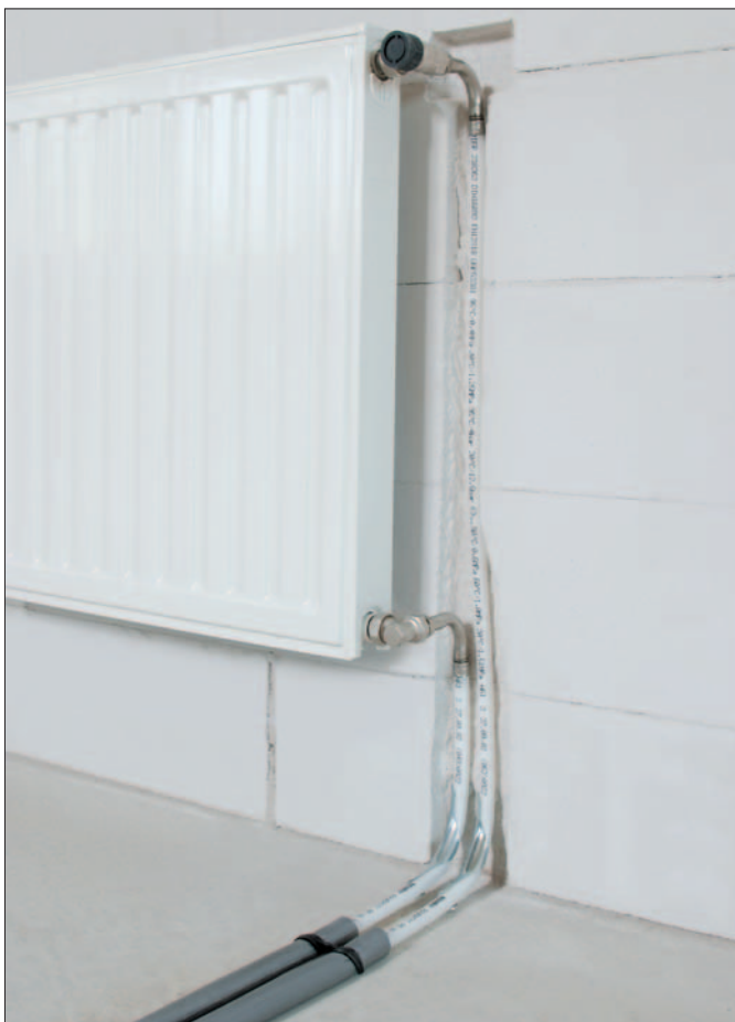
Exemplu de montaj: Racordarea unui radiator din perete
