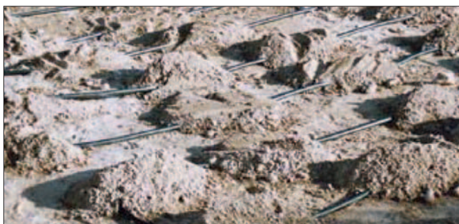
Pozarea tubului RAUGEO collect PE 100
