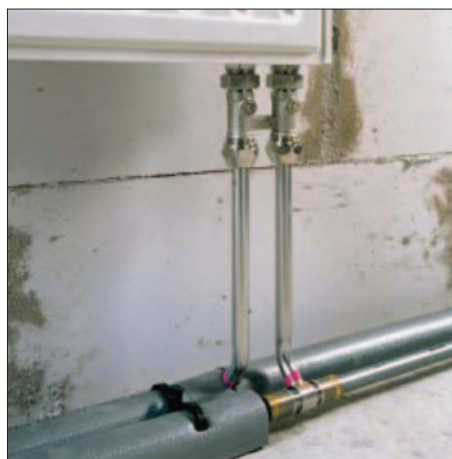
Racordarea radiatorului la o distribuție inelară
