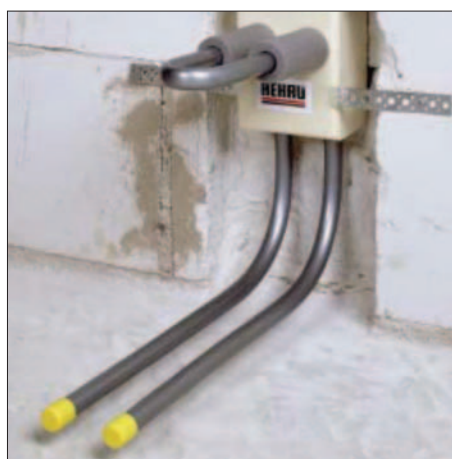
Bloc de racord RAUTITAN la corpurile de încălzire
