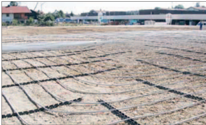
Pozarea tubului RAUGEO collect PE-Xa
