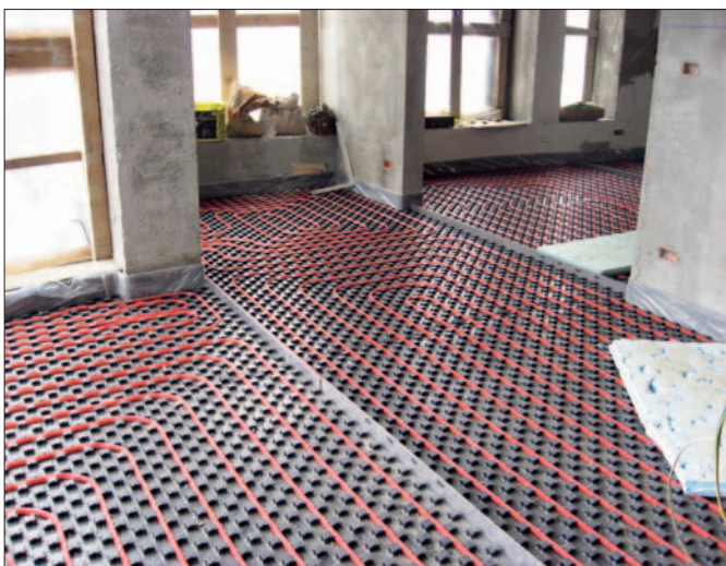
Încălzire pardoseală sistem cu placă Varionova
