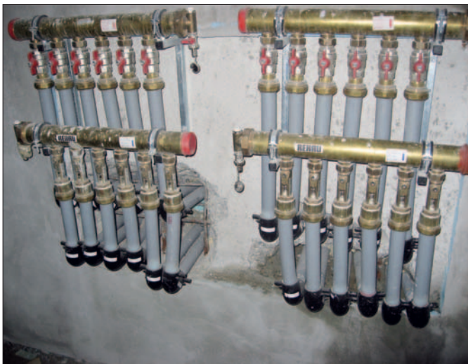
Distribuitor-colector pentru sonde RAUGEO
