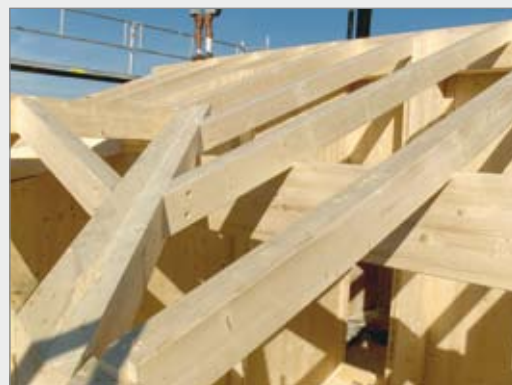
Joncțiune grindă secundară - grindă principală cu șuruburi HBS solicate la tăiere
