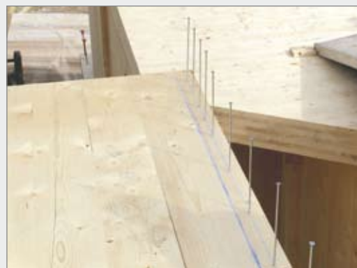
Legătură tavan-perete al unei clădiri din lemn
