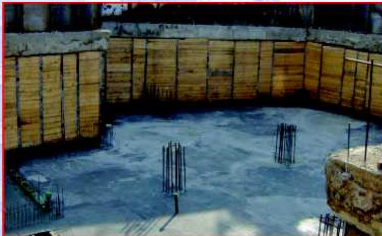
Sprijinirea Berlineză este o lucrare provizorie de sprijinire a incintelor sau a taluzurilor, care poate fi folosită numai în condițiile în care nivelul hidrostatic se găsește sub cota finală de excavație cu cel puțin 50cm.
