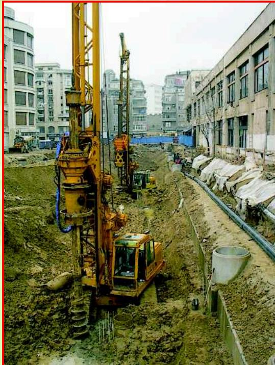
Pentru realizarea unor elemente structurale de transmitere în adâncime a încărcărilor aduse de construcții, Züblin România execută frecvent toate tipurile de piloți de diametru mare ( $\varnothing=400\div 1500$  mm), în fiecare amplasament aplicând tehnologiile cele mai potrivite.
