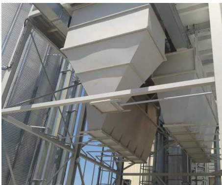
Decantare in rezervoare
