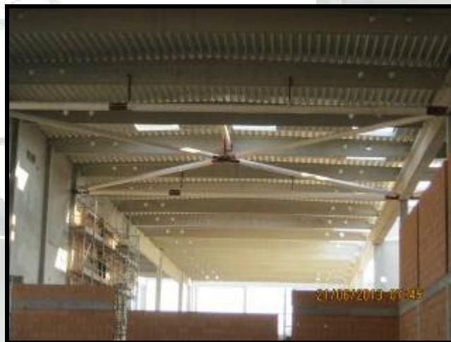
Montaj structura metalica Lego Nyíregyháza (peste 450 to)
