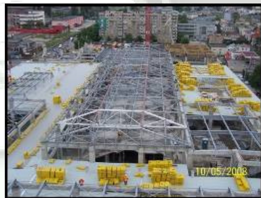
Montaj structura metalica depozit de cereale - Mezőhegyes UNGARIA
