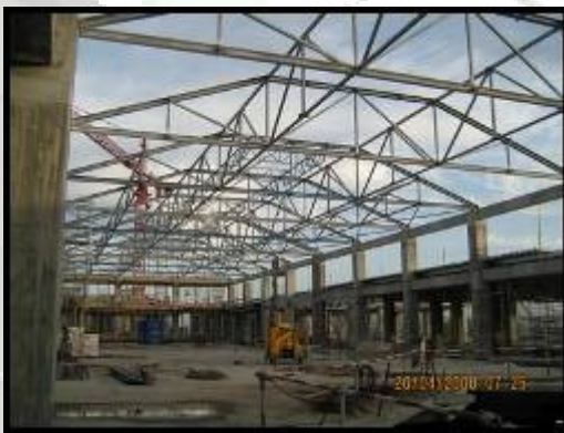
Montaj structura metalica depozit de cereale - Mezőhegyes UNGARIA
