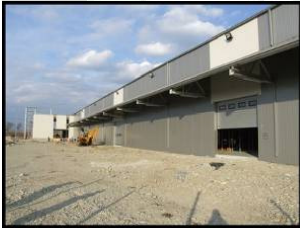
Montaj structura metalica birouri si depozit Irina Impex – Ramnicu Valcea – suprafata hala 2400 m2 si 330 t structura metalica
