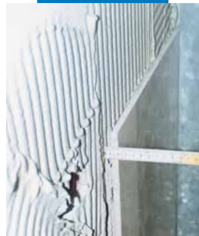
Aplicarea plăcilor porțelanate în strat gros pe un perete
