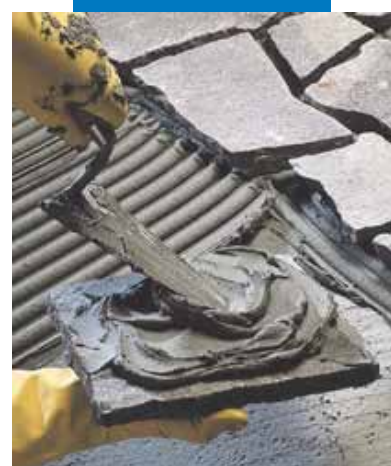
Montarea la exterior a pietrelor nefinisate, prin sau fără metoda dublei aplicări, în funcție de grosimea stratului.
