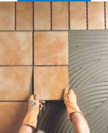
Montarea la exterior a plăcilor de klinker
