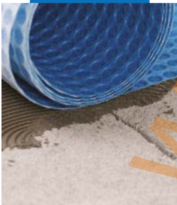
Instalarea Mapeguard UM 35
