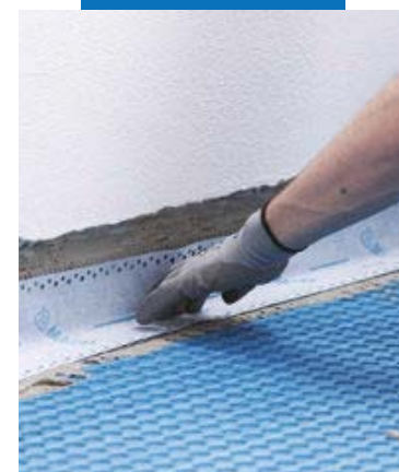
Hidroizolare perimetrală cu Mapeband Easy, lipită cu adeziv Mapeguard WP Adhesive
