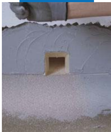
Hidroizolarea scurgerilor cu drain front
