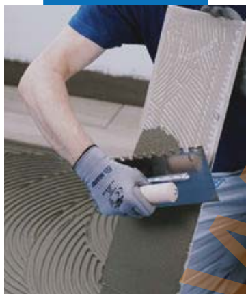
Instalarea ceramicii sau pietrei naturale cu un adeziv Mapei cel putin clasa C2
