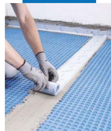
Hidroizolarea rosturilor dintre fasii cu Mapeband Easy, lipită cu adeziv Mapeguard WP Adhesive
