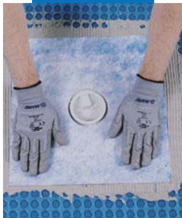
Hidroizolarea scurgerilor cu Drain Vertical/Drain Lateral
