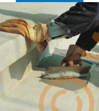
Aplicarea Adesilex PG1 cu o spatulă dințată la lipirea structurală a treptelor prefabricate
