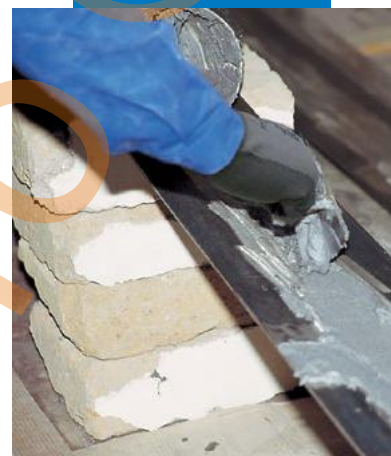
Aplicarea Adesilex PG1 pe o platbandă metalică
