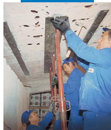
Aplicarea platbandei metalice pentru armarea structurală
