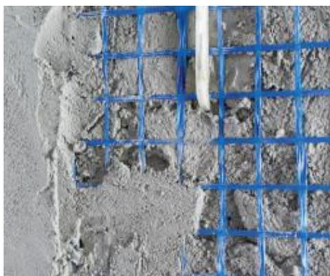
Applicazione del secondo strato di MapeWall Intonaca & Rinforza
