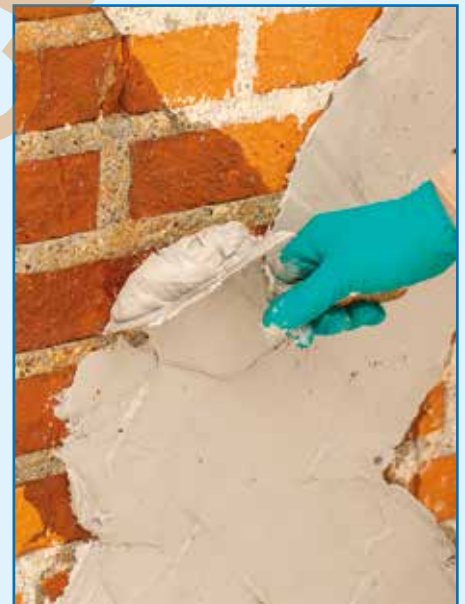
Skim-coat of MapeWrap 11 or MapeWrap 12
