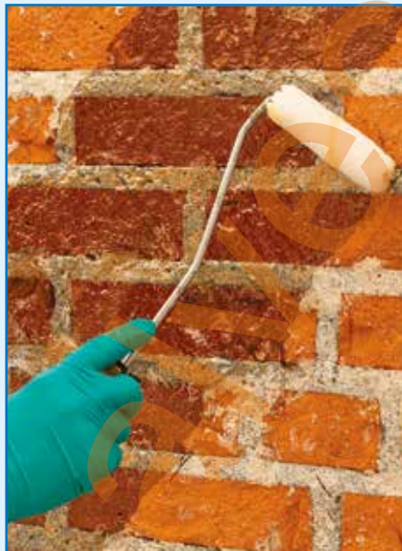
Application of MapeWrap Primer 1
