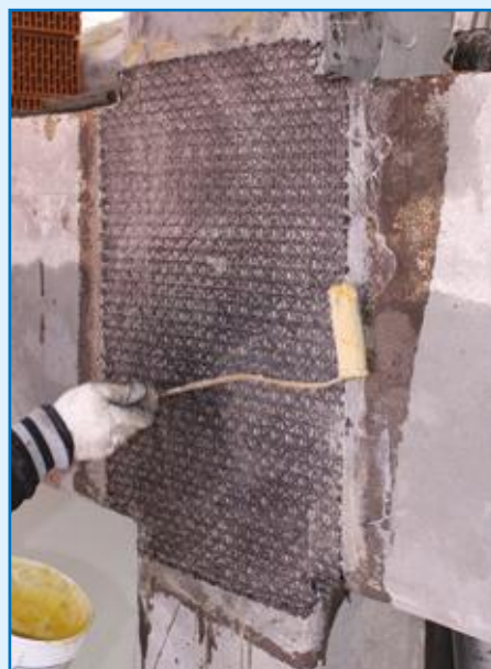
Seconda mano di MapeWrap 31
