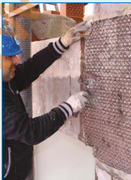
Applicazione del tessuto MapeWrap C QUADRI-AX
