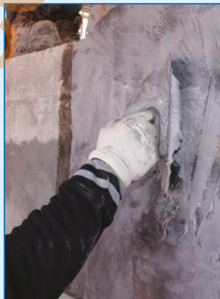
Rasatura con MapeWrap 11 o MapeWrap 12
