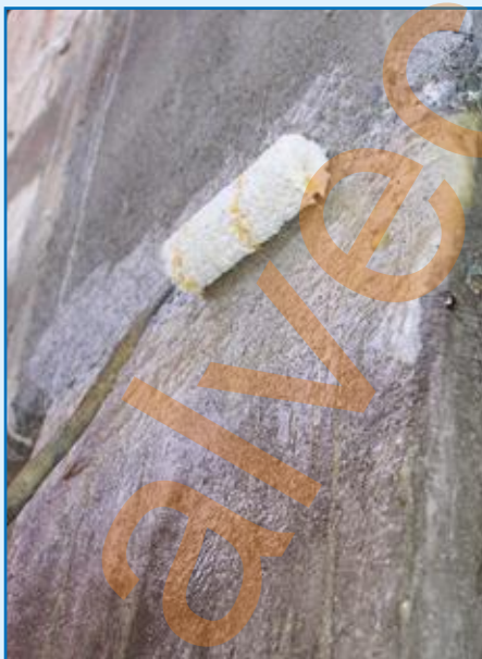
Applicazione di MapeWrap Primer 1
