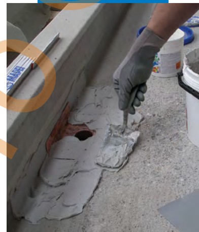
Finisare ulterioară cu Adesilex PG4
