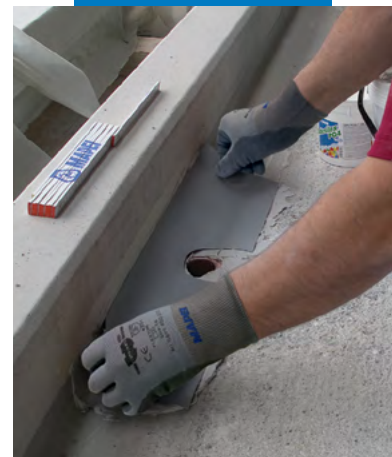
Poziționare profil flexibil din hyphalon
