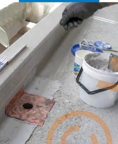
Positionarea unei flanse din cupru cu umăr și a unei țevi de scurgere
