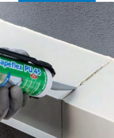
Etanșarea flexibilă a rosturilor de construcții
