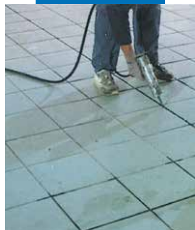
Etanșarea rosturilor cu Mapesil AC la o pardoseală din plăci ceramice
