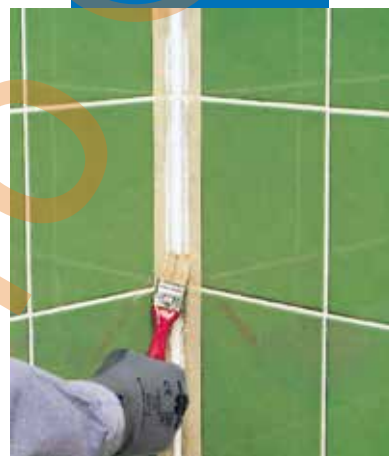
Umezirea etanșantului cu o soluție din apă și săpun în vederea finisării
