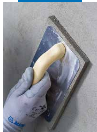
Drișuirea mortarului Planitop Rasa & Ripara R4
