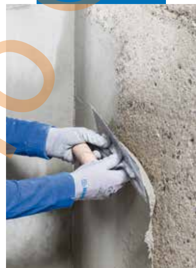
Aplicarea Planitop Rasa & Ripara R4 cu un fier de glet
