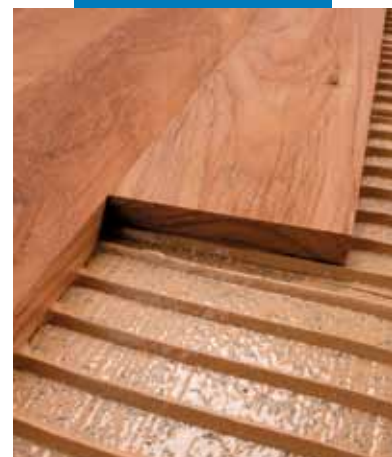
Lipire de parchet pe adeziv conform standardelor
