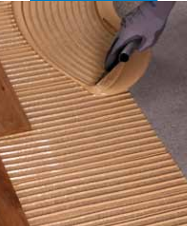
Montare de parchet masiv pe șapă Topcem
