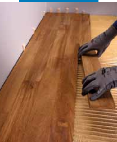
Montare de parchet cu dimensiune mare
