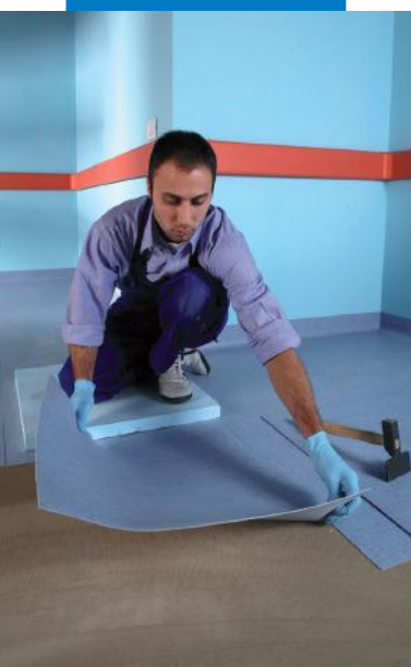
Montarea dalelor din PVC
