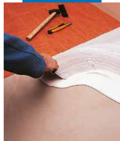
Intinderea adezivului Adesilex V4 si lipirea dalelor din PVC omogen
