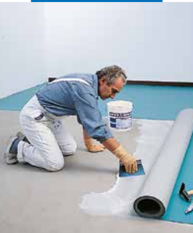
Intinderea adezivului Adesilex V4 si lipirea covorului din PVC eterogen in camp continuu
