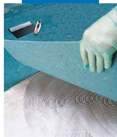
Lipirea dalelor din PVC omogen cu Adesilex V4
