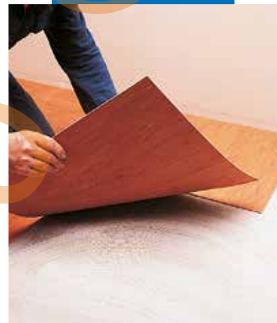
Montajul dalelor din PVC omogen cu Adesilex V4
