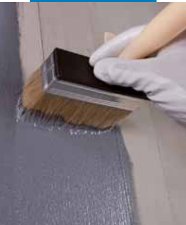
Aplicarea de Eco Prim Grip pe beton, cu bidinea
