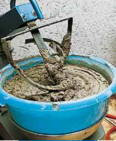
Pregatirea amestecului cu minibetoniera
