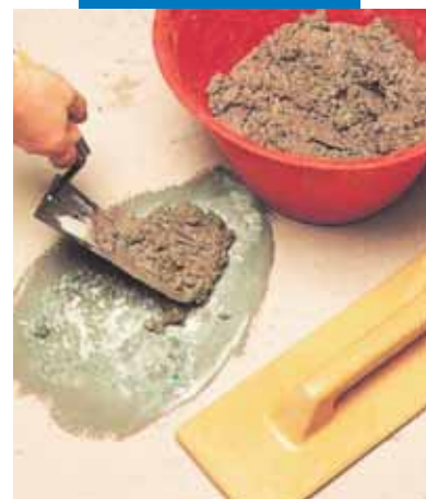
Reparatii localizate la pardoseli: aplicarea mortarului
