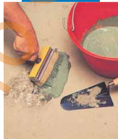
Reparatii localizate la pardoseli: aplicarea amorsei de aderenta
