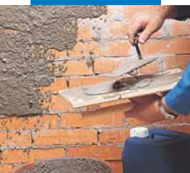
Aplicarea spritului adeziv aditivat cu Planicrete
