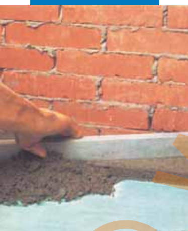
Aplicarea sapei pe baza de ciment aditivată cu Planicrete
