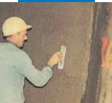
Tencuiala pe baza de ciment cu Planicrete. Tunel autostrada Ville Marie, Montreal, Canada
