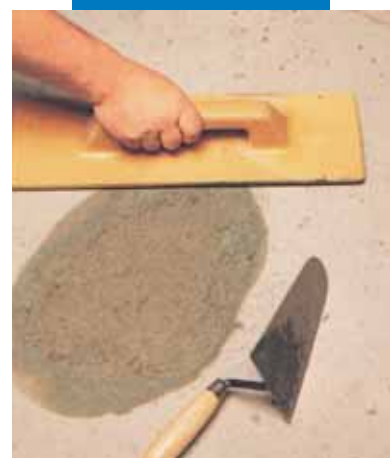
Reparatii localizate la pardoseli: finisarea suprafetei
