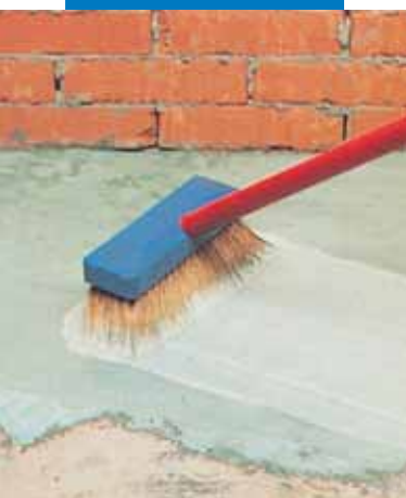
Aplicarea amorsei de aderență pe baza de ciment aditivată cu Planicrete
