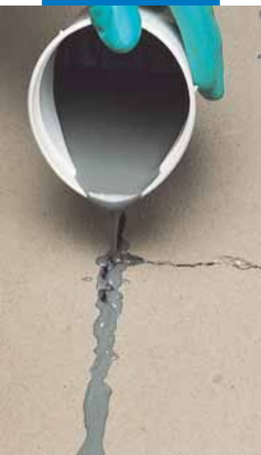
Repararea unei fisuri la o șapă pe bază de ciment folosind Eporip
