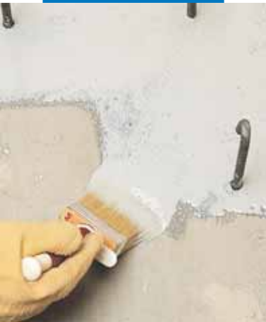
Aplicarea Eporip prin pensulare la un rost de turnare
