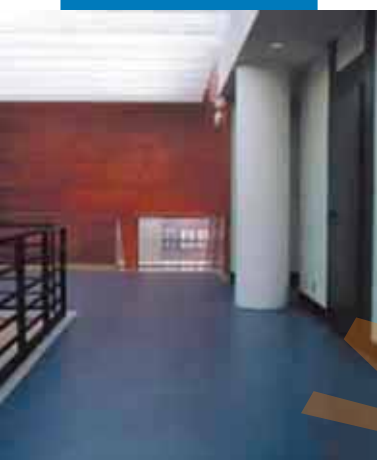
Exemplu de instalare a linoleumului pe o suprafață nivelată cu Ultraplan - Conservatorul Monzon - Spania
