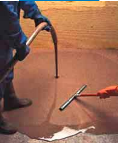
Aplicarea șapei autonivelante Ultraplan cu pompă și racletă
