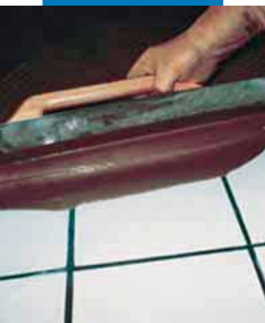
Aplicarea șapei autonivelante Ultraplan cu spatula metalică pe o pardoseală din plăci ceramice amorsată cu Mapeprim SP
