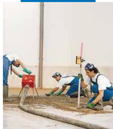
Aplicarea si nivelarea mortarului de Topcem
