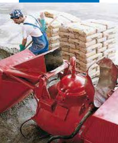
Realizarea amestecului Topcem cu o pompa automata cu presiune
