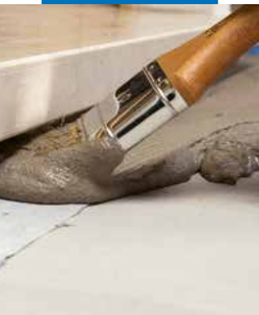
Aplicarea de Mapeband SA in locuri dificile ca pragul de usa
