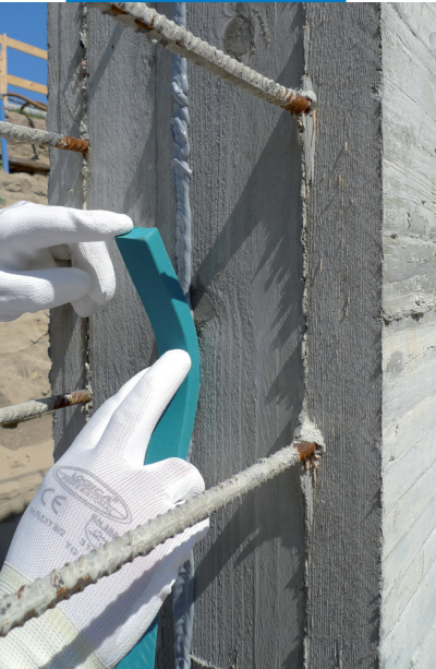
Aplicarea Idrostop Soft pe suprafețe verticale
