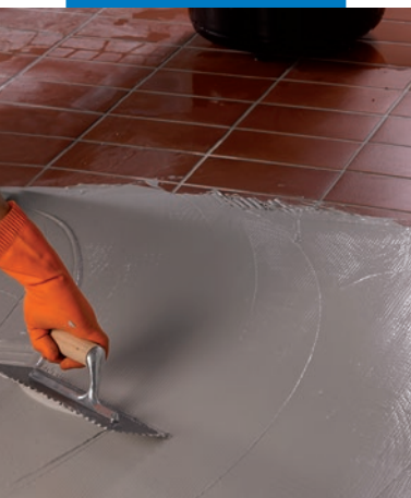
Aplicarea celui de-al doilea strat de Monolastic peste Mapenet 150
