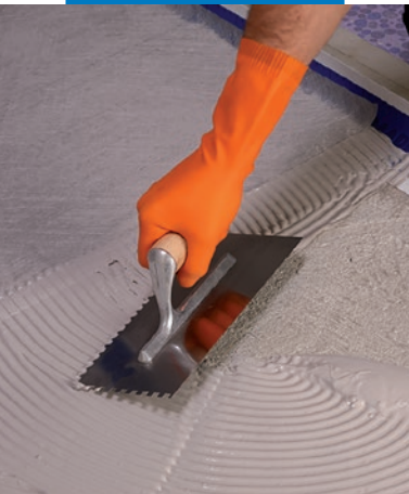
Aplicarea primului strat de Monolastic armat cu Mapetex Sel pe o șapă nouă
