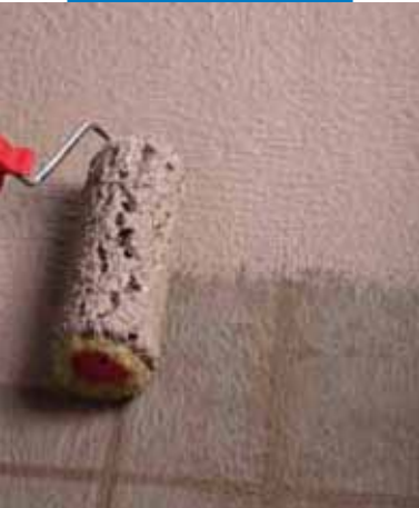
Hidroizolarea unei terase aplicând materialul cu trafaletul
