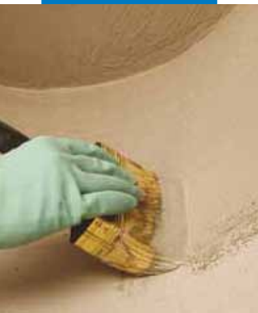
Hidroizolarea unei terase aplicând materialul cu bidineaua
