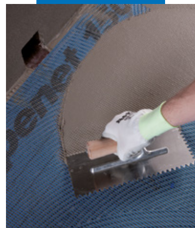
Aplicare Mapelastyc pe Mapebet 150
