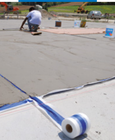
Hidroizolarea șapelor cu Mapelastic și Mapeband
