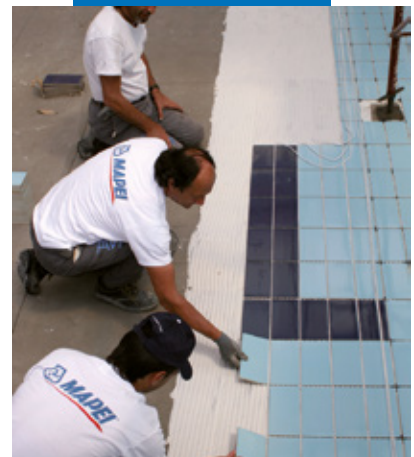
Punerea în operă a plăcilor ceramice pe hidroizolația Mapelastic
