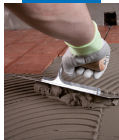
Aplicare Granirapid pe o terasă hidroizolată cu Mapelastyc
