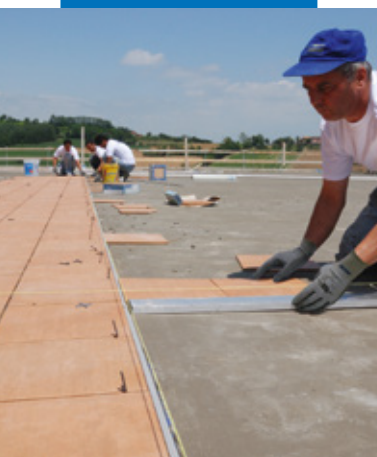
Instalarea plăcilor ceramice cu Kerabond + Isolastic
