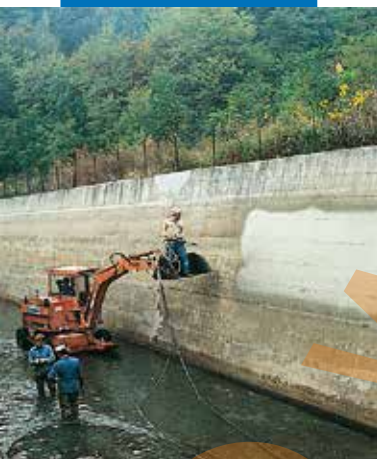
Planiseal 88 aplicat prin pulverizare într-un canal hidroelectric
