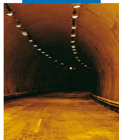
Planiseal 88 alb aplicat prin pulverizare într-un tunel de autostradă
