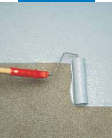
Aplicarea Mapecoat I 24 cu trafaletul
