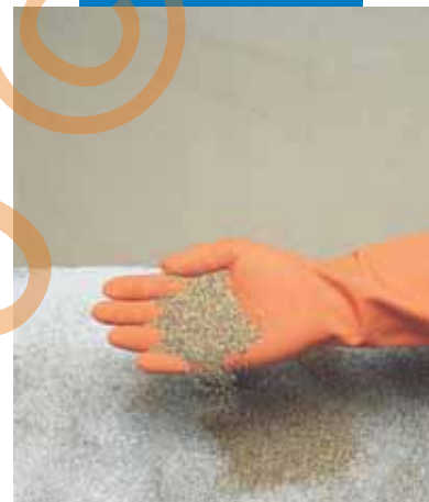
Imprastierea nisipului uscat pe stratul proaspăt de Mapecoat I 24
