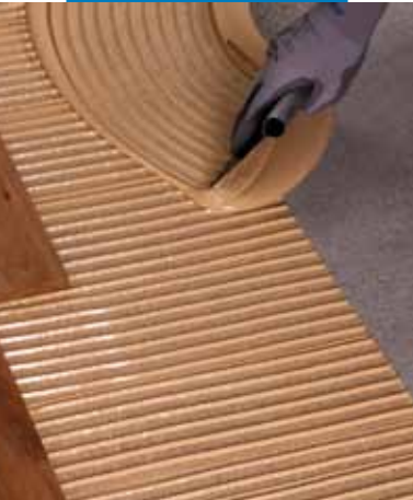
Montare de parchet masiv pe șapă Topcem
