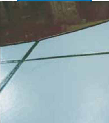
Detaliu la aplicarea sapei autonivelante Ultraplan pe o pardoseala din placi ceramice amorsata cu Mapeprim SP
