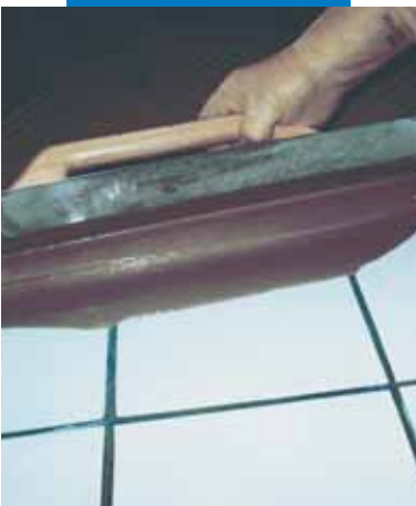
Aplicarea sapei autonivelante Ultraplan cu spatula metalica pe o pardoseala din placi ceramice amorsata cu Mapeprim SP
