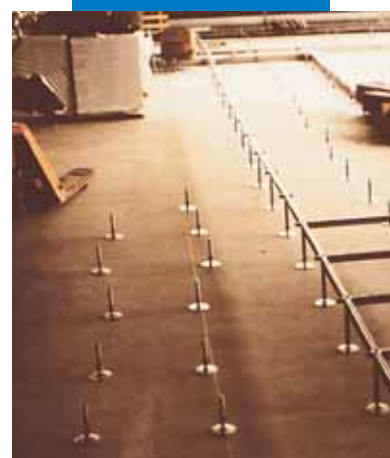
Substrat nivelat cu sapa autonivelanta Ultraplan gata pentru instalarea unei pardoseli tehnice
