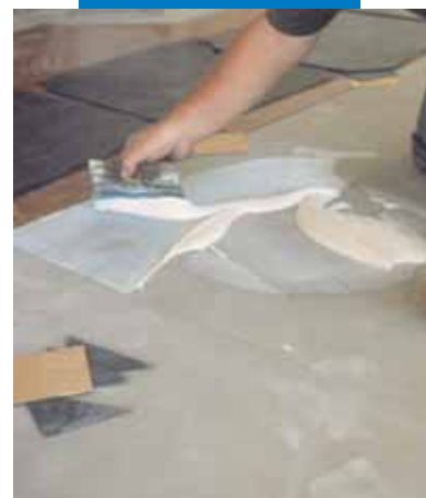
Exemplu de instalare a covorului PVC pe o suprafata nivelata cu sapa autonivelanta Ultraplan - CD2 - Milano - Italia
