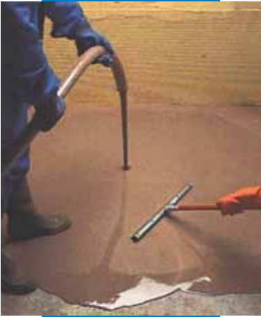
Aplicarea sapei autonivelante Ultraplan cu pompa si racleta
