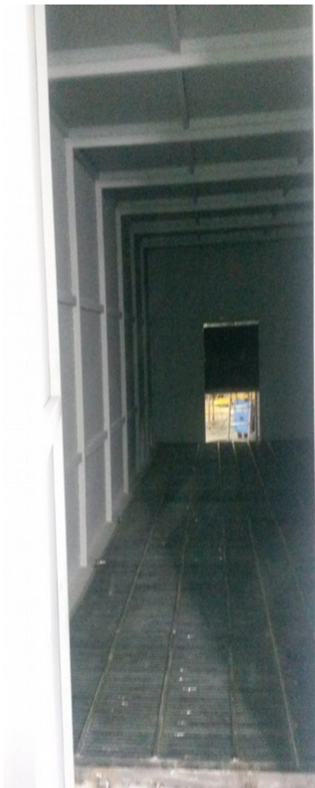
8. Cabină cu accesul sablorului din interior, vedere din față
