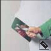
0,3-0,5m<sup>2</sup> spessore 0,5 mm thickness 0,5 mm 6h
