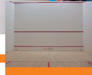
Ein Squashcourt nach der Renovierung mit einer CT Wand
