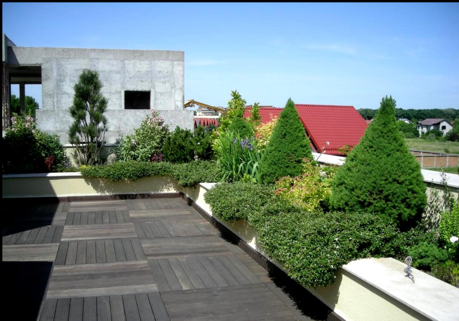
Amenajare și întreținere terasă – Pipera, Ilfov.
