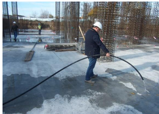
Fig. 6. Stropirea suprafetei cu apa timp de 5 zile
