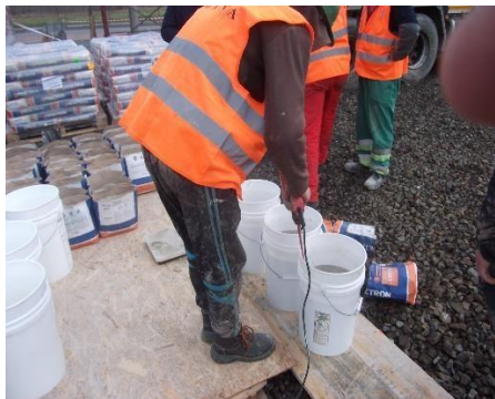
Fig.1 -Galeti cu 11,5l de apa
