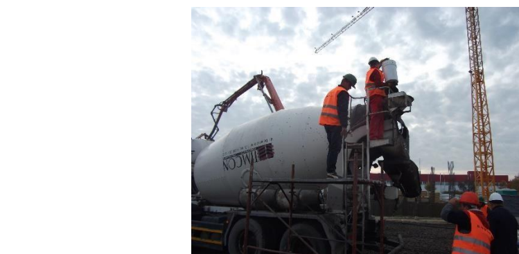
Fig.4- Adaugare amestecului in CIFA , viteza de rotatie maxima , timp amestec 1min./m 3 .
