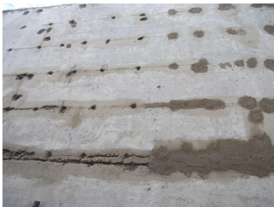
Fig 9- Reparatii defecte de turnare (segregari,lamele,dopuri,etc)
