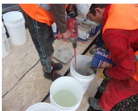
Fig.3- Amestecare 1/2 sac cu 11.5 l apa timp de 30 sec-40 sec.
