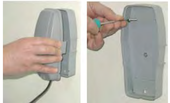
Montarea întrerupătorului principal folosind trei bosaje de montare de pe capacul din spate
