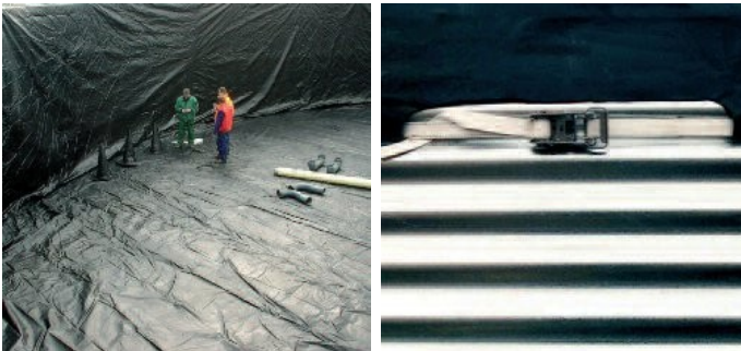
Tensionarea foliei de retenție pentru marginea rezervoarului metalic se face printr-o cusătură, prevăzută cu o curea și cataramă de oțel inoxidabil cu clichet
